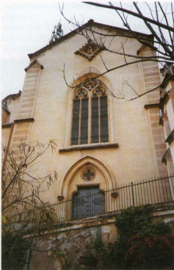
FOTO 3. Vista lateral amb detall de la façana que dona al parc de Canyelles
