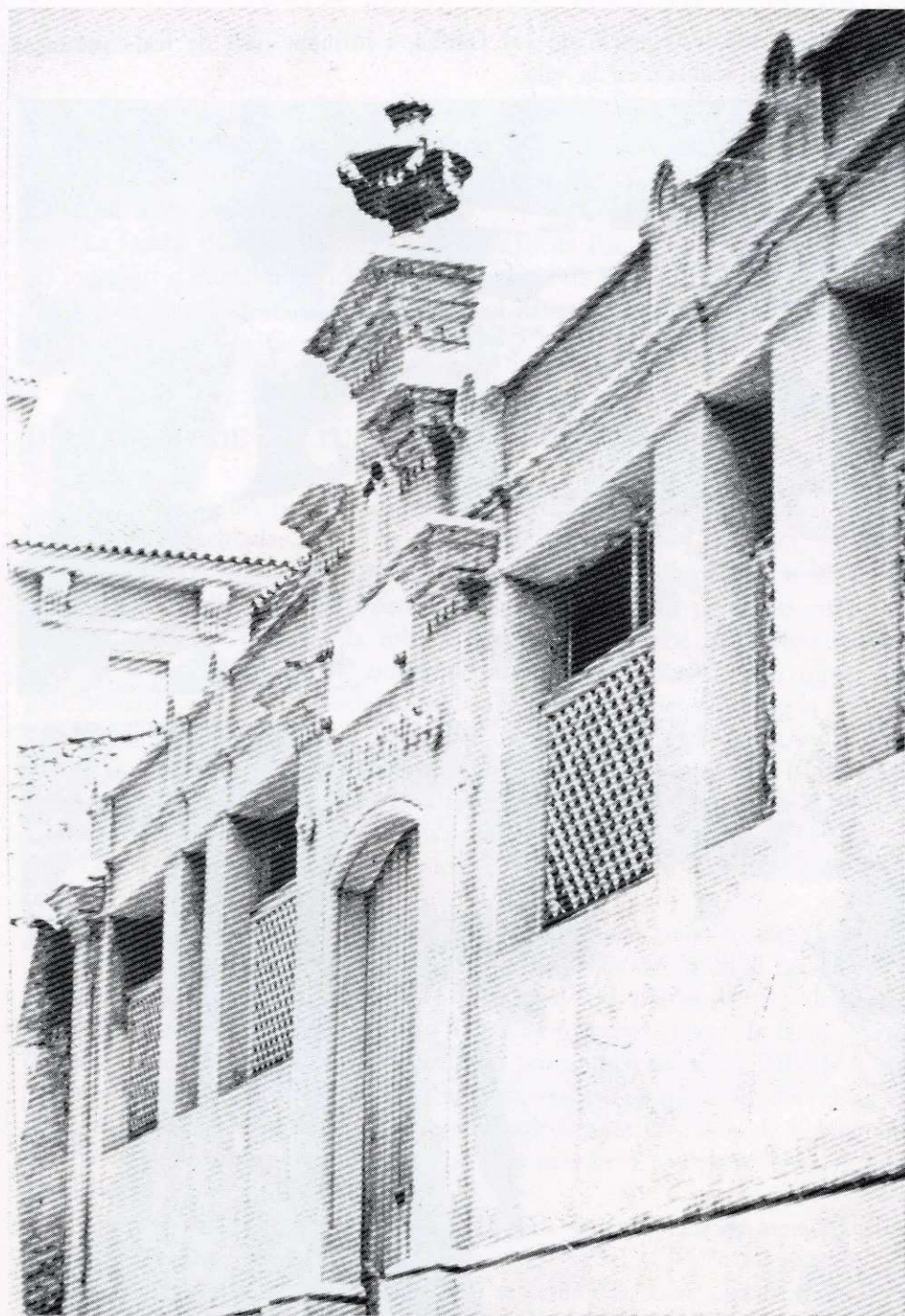
Façana abans de la rehabilitació
