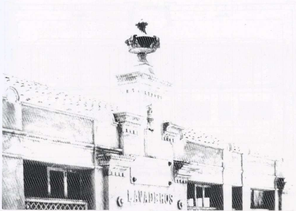
Detall de l'ornamentació de la cornisa abans de la seva rehabilitació
