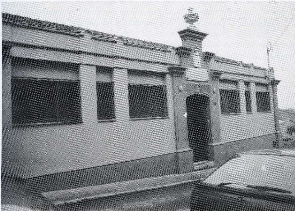
Vista actual de l'edifici
