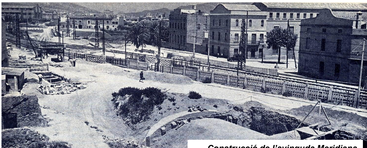
Construcció de l'avinguda Meridiana
