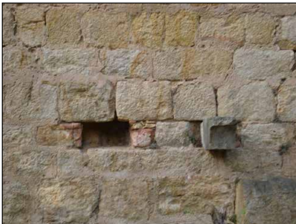
Foto 1: Mènula al mur de la galeria claustral amb l'encaix de la seva parella al costat, que devia sostenir una ossera (fotografia J. Vellvehí).
