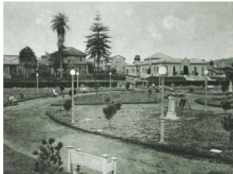
Figura 31- Fotografía del Parque España entre 1910 y 1925.
