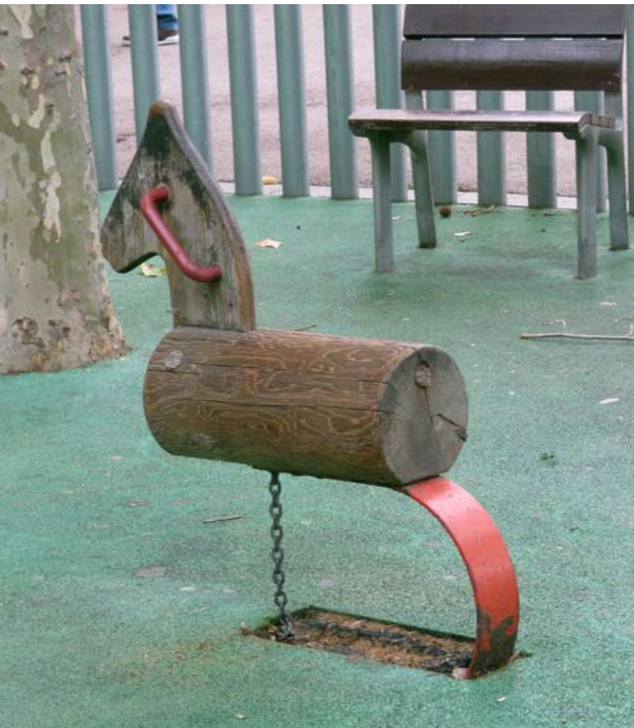
Figura 9: Caballo Móvil. (1) Corte del tronco en ángulo. (2) Desgaste en pintura sobre superficie metálica
