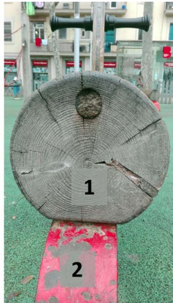
Figura 9: Caballo Móvil. (1) Corte del tronco en ángulo. (2) Desgaste en pintura sobre superficie metálica
