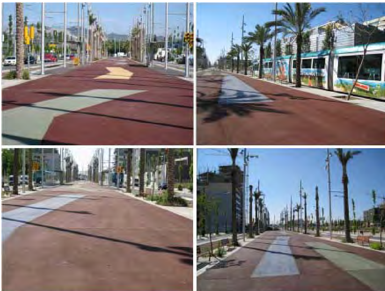
Vistas do estado actual de execução da Rambla de La Mina Fonte – Remesar, 2008
