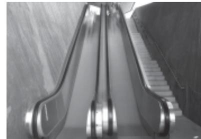
Com um comprimento total de 100 metros, as escadas rolantes dividem-se em seis tramos distribuídos segundo um padrão de zig-zag, que vencem um desnível de 36 metros e seguem a topografia do local, aparecendo como uma fenda na muralha.
