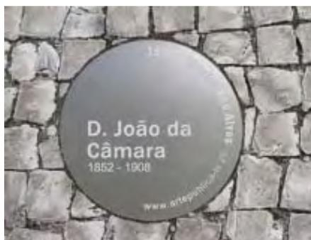
Em qualquer dos casos, a placa deve assentar em toda a superfície na sapata de cimento, ou em elementos amortecedores na base de pedra de modo a evitar deformações da mesma. Recomenda-se fortemente que os remates da placa sejam cuidadosamente realizados pelos calceteiros para assegurar a boa integração no pavimento e, principalmente, para evitar ressaltos ou desníveis que funcionem como obstáculo à circulação pedonal.
