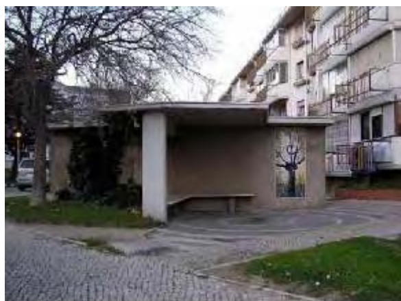
Bloco de arrendações dos edifícios em banda - Olivais Norte - Fotografia actual
