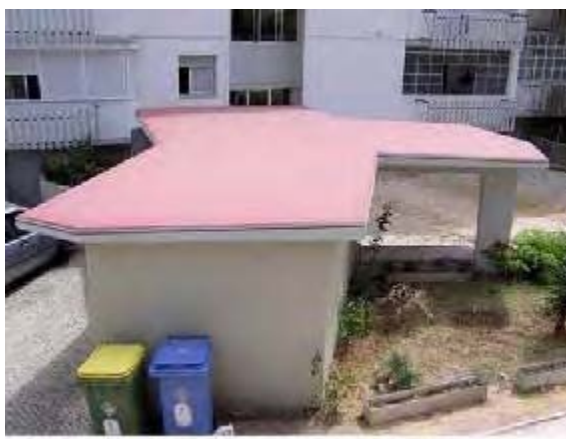
Bloco de arrendações dos edifícios em banda - Olivais Norte - Fotografia actual
