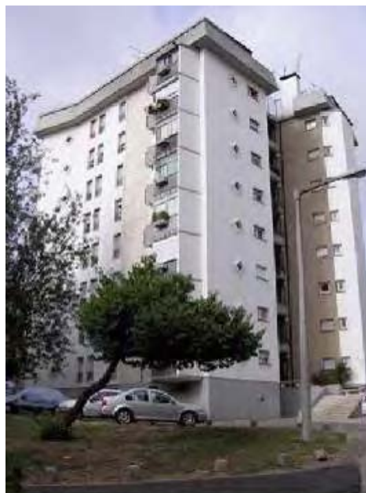
Torre de Habitação em Olivais Norte. Autores: Nuno Portas; Nuno Teotónio Pereira; António Pinto Freitas. Data de projecto: 1957. Data de conclusão: 1968
