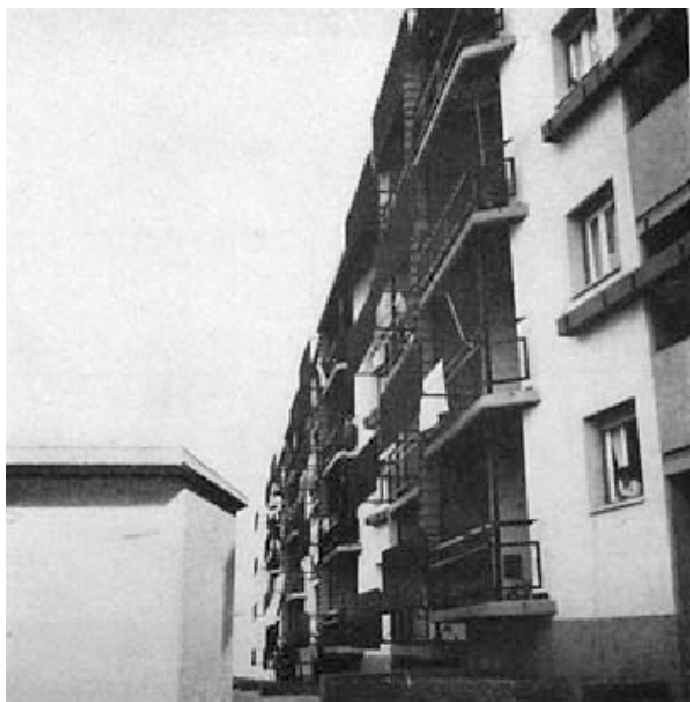
Edifícios em banda em Olivais Norte. Data projecto: 1957. Data conclusão: 1961. Autores: Nuno Teotónio Pereira; António Pinto Freitas - Extraído de Revista Arquitectura n.º81, Março de 1964
