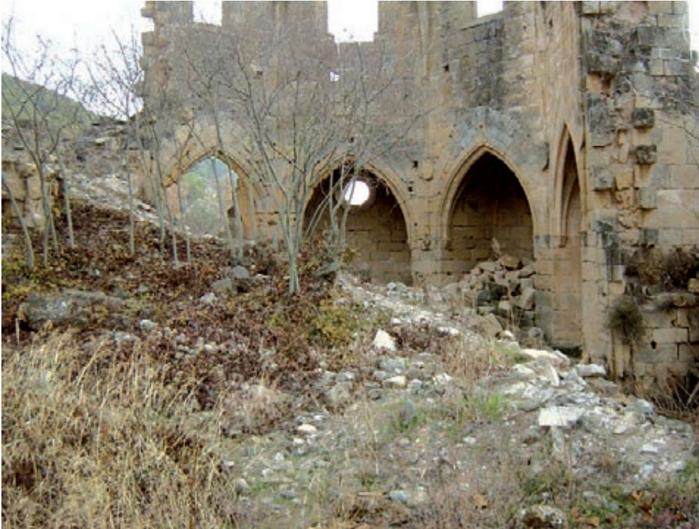
Figura 2. Detall de l'estat d'enderroc de l'edifici de l'església abans de la intervenció.
