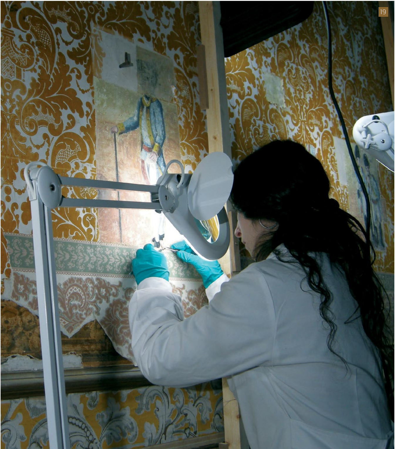
[19] Procés d'eliminació del paper pintat (Fotografia: Rickerby&Shekede).
