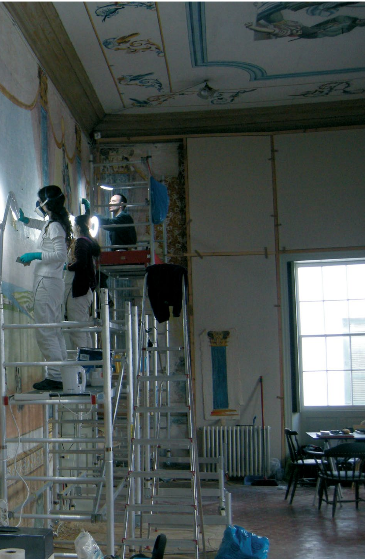
[27] Detall d'intervenció en el mur sud (Fotografia: Rickerby&Shekede).
