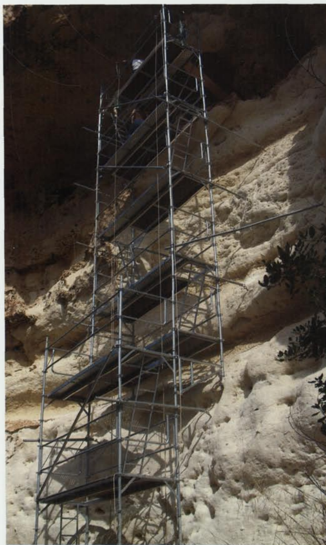
2. Bastida col·locada a l'entrada de la cavitat per a poder-hi accedir amb seguretat (Fotografia: Equip d'excavació).
