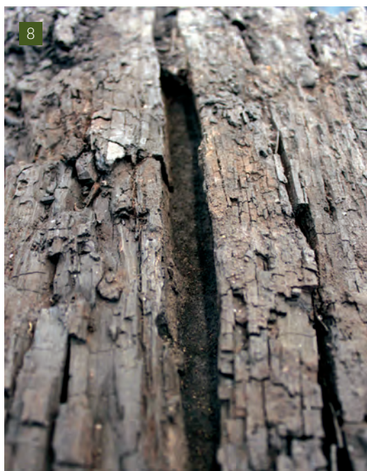
[8] Detall d'una esquerra reintegrada amb Balsite® (Fotografia: Delia Eguiluz, Sandra Caballero i Ruth Sadurní).
