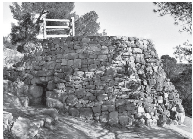
Figura 18. Vista del costat sud del forn un cop restaurat.
