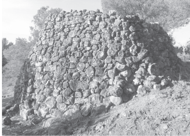
Figura 21. Vista del mur extern.
