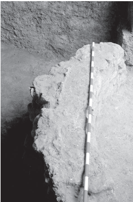
Figura 5. Mur sud de l'estructura circular amb l'empremta deixada pels carreus sobre el morter de calç del coronament del mur.
