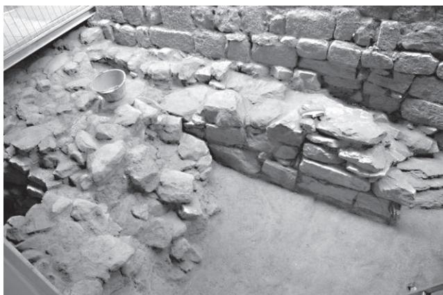
Figura 16. Procés de consolidació de les restes de la torre de la muralla protohistòrica.
