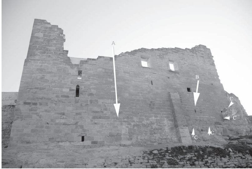
Figura 20. Exterior de l'espai IV, que correspon a la cara externa del mur de ponent del castell. A.- Junta de fàbrica de l'estructura (antiga torre?) en la qual s'allotgen els dos trulls cilíndrics possiblement de vi. B.- Finestreta que coincideix amb l'àrea d'excavació de l'espai IV.1. C.-Llínea del nivell de roca natural, rebaixada per a encaixar el revestiment dels carreus -també s'evidencia canvis de mòdul en els carreus.
