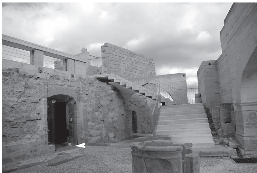
Figura 1.- Vista central del pati del castell. La fletxa indica el punt 0, situat a la base del costat dret de la porta.
