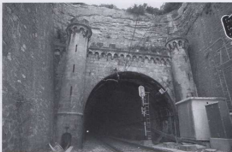
Entrada túnel (Vinaixa)
