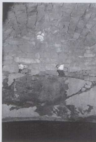
Cabana aljub a la finca del Mas del Metge. Vista de la façana i de l'interior.
