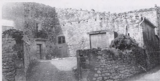
Foto 1. Edifici del forn de vidre, situat entre el carrer Major i el carrer Orient. Fotografia dels anys setanta, realitzada per Ramon Santamaria.
