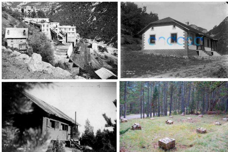
Figura 11. A dalt a l'esquerra, fotografia amb vista lateral del Xalet de La Molina. Al darrere, la llimplia, i al fons, la Torre Olano (font: fotografies de Jaume Boixader, Àlbum I (1) 71, Arxiu del Museu de les Mines de Cercs). A dalt a la dreta, fotografia de l'any 1930 del xalet de FECSA (font: ID 21563, Arxiu Fondo Histórico ENDESA). A baix a l'esquerra, vista lateral de la Casita de Papel (font: cedida per Josep Oriola). A baix a la dreta, vista de l'estat actual de la Casita de Papel, amb els pilars que en sostenien l'estructura. Font: elaboració pròpia
