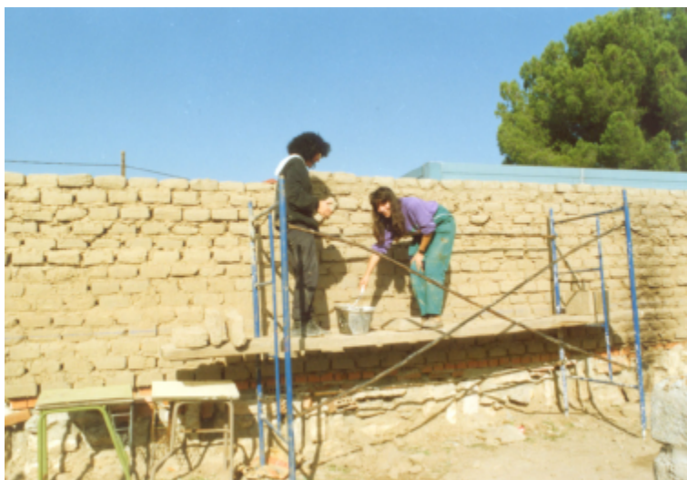
Figura 8. Especialidad de albañilería. Elaboración de un muro de adobe.
