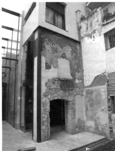
Carrer dels Gavatxons, 5. Façana que dona a la plaça de la Torre del Palau. Conservació d'un fragment de muralla corresponent al tram est. Fotografia: Antonio Moro.
