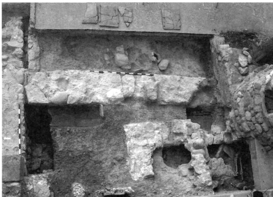
Fotografia 4. Àmbit funerari devocional de la primera fase constructiva localitzat davant de la façana est de l'edifici de la rectoria. Fotografia: Excavació 2001-03/Museu de Terrassa.
