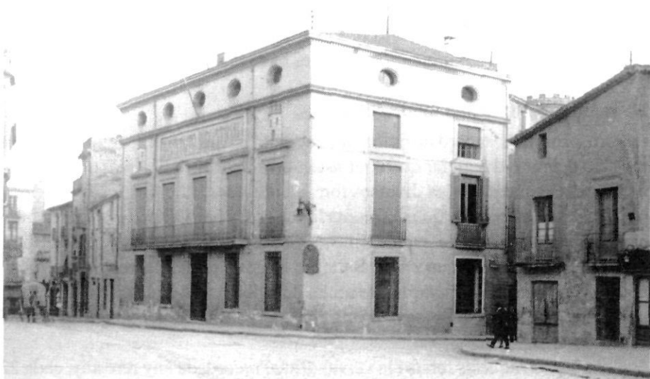
Façana de l'Institut Industrial, amb la placa commemorativa dels fets del 22 de Juliol, col·locada l'any 1883. Fotografia: Miquel Astals i Mach/Arxiu Tobella.
