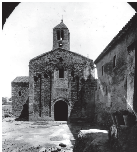
Església i edifici de la canongia, ja iniciats els treballs de rebaix del terreny i enderroc de la canongia, 1917. Arxiu Mas.
