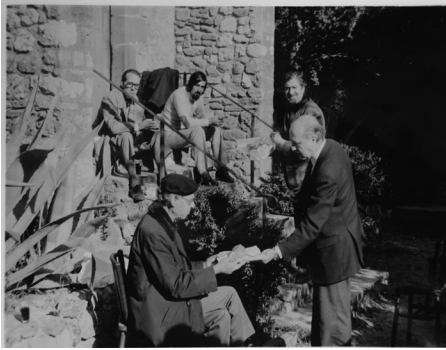
Visita d'obres de la restauració dirigida per l'arquitecte Jordi Ambrós entre 1975 i 1982. Hi apareixen Jordi Ambrós, Jeroni Font, Salvador Alavedra i una altra persona. Museu de Terrassa.
