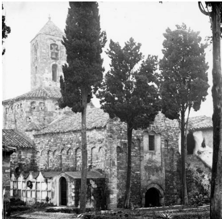
Església de Santa Maria, edifici de la canongia i nínxols del cementiri abans de 1917. Fons Salvany. Biblioteca de Catalunya.
