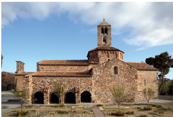
Fig.2 Vista sud de l'església de Santa Maria on observem el tram del claustre amb les arcades. Fotografia Museu de Terrassa / Antonio Moro (maig de 2009).
