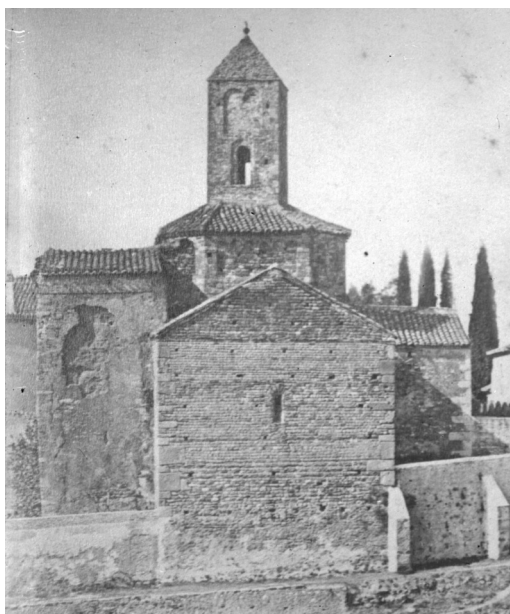
Fig.3 Detall aproximat de fotografia general del conjunt on distingim l'extrem est de la canongia, que sobrepassava el braç sud de l'obra romànica. Molt probablement, substituiria una altra edificació anterior de la qual no hem vist les restes. El pis superior, relacionat amb les estances de dormitori dels canonges, presenta una degradació a la tàpia que en denota la fragilitat i inestabilitat, com descriu el corresponent document. La planta baixa, relacionada amb sengles portes conservades avui dia a l'interior del braç sud de l'església, fan pensar en un ús de sagristia. Aquest cos seria desmantellat poc després del mes de març de 1878, com així es desprèn d'una petició d'enderroc del mossèn Joaquim Salas. Fotografia d'A. Torija, c. 1878. Museu de Terrassa, número d'inventari 18.956.
