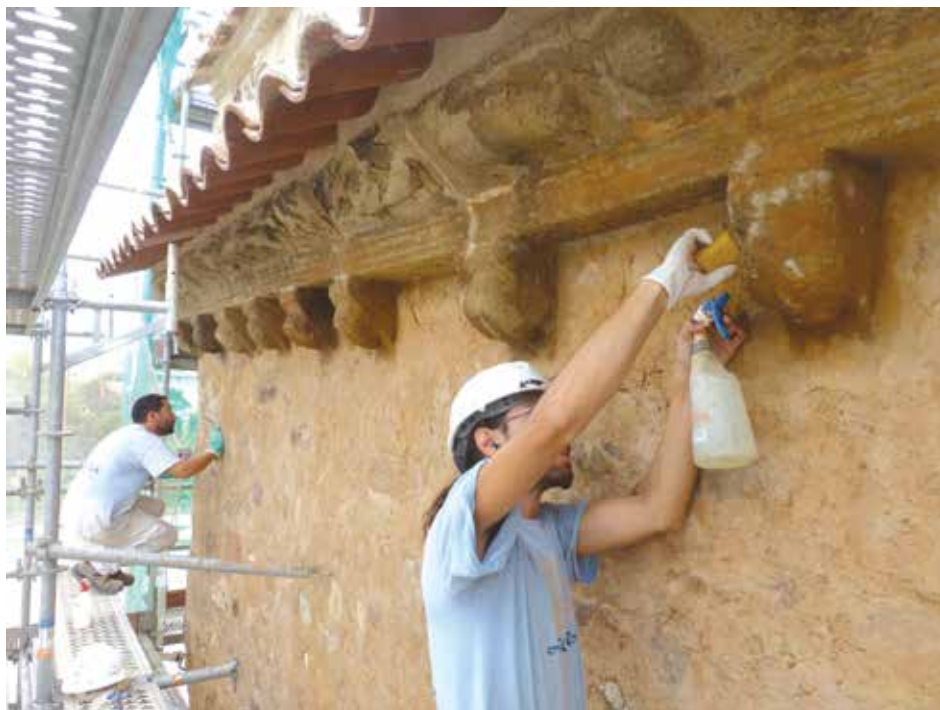
Treballs de restauració. Autoria: Museu de Terrassa.
