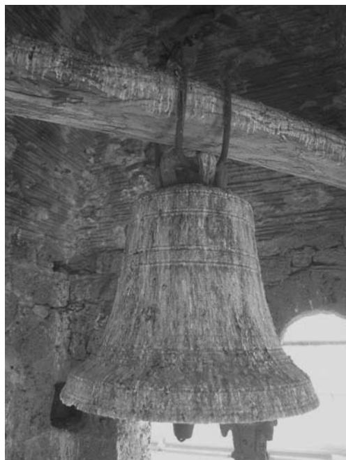
Vista des de l'interior del campanar de Santa Maria, on podem observar la campana i el seu badall, la columna i el capitell d'una de les finestres i el sostre piramidal de la coberta, on s'aprecia l'encanyissat. Autor: Antonio Moro (Museu de Terrassa).
