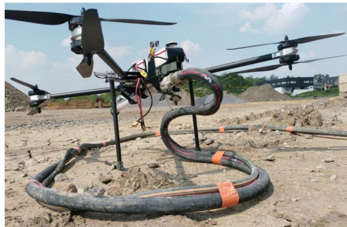
Fig. 10. Mànega del polvoritzador de morter connectada al dron per disposar de subministrament de material constant.
