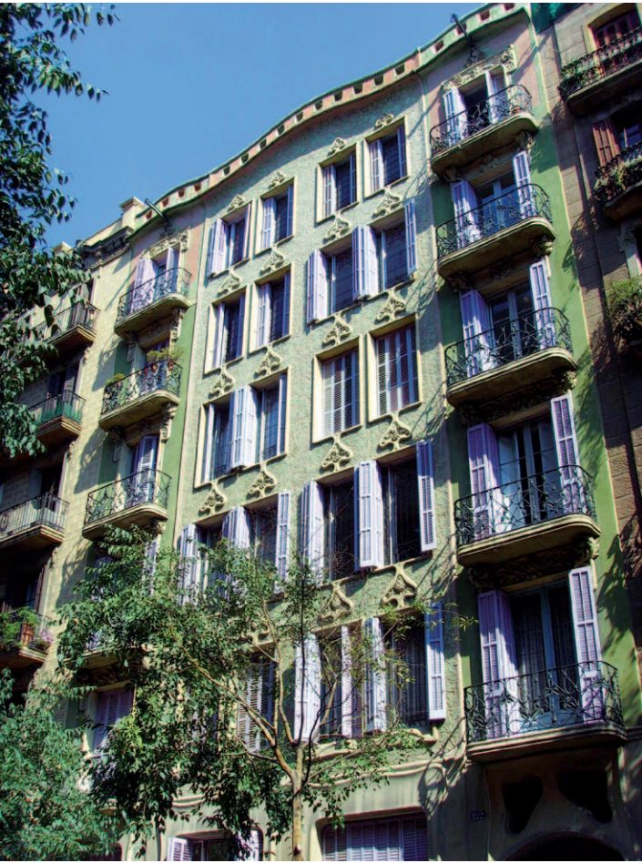
▲ Rehabilitación de la fachada de Girona, 122 en Barcelona
