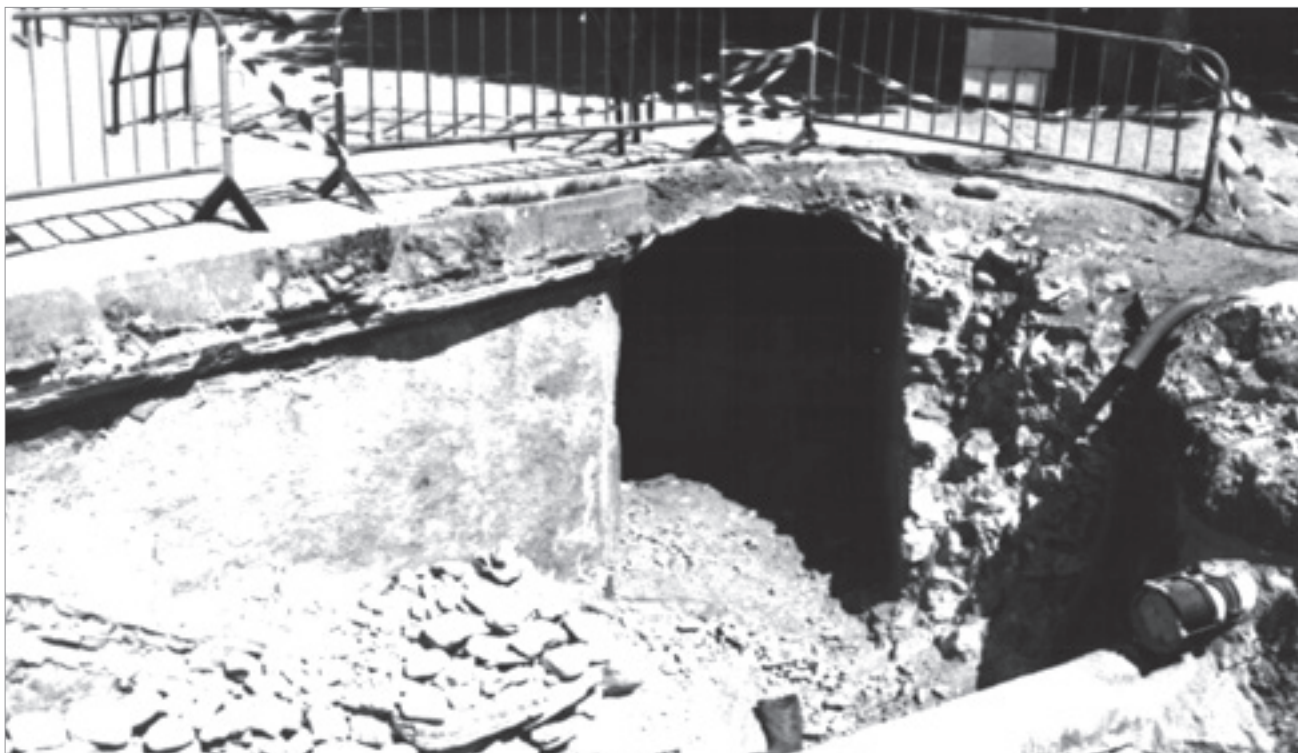
Refugi antiaeri de la Guerra Civil. Girona / Ajuntament de Girona. CRDI © Francesc Subiràs Juncà
