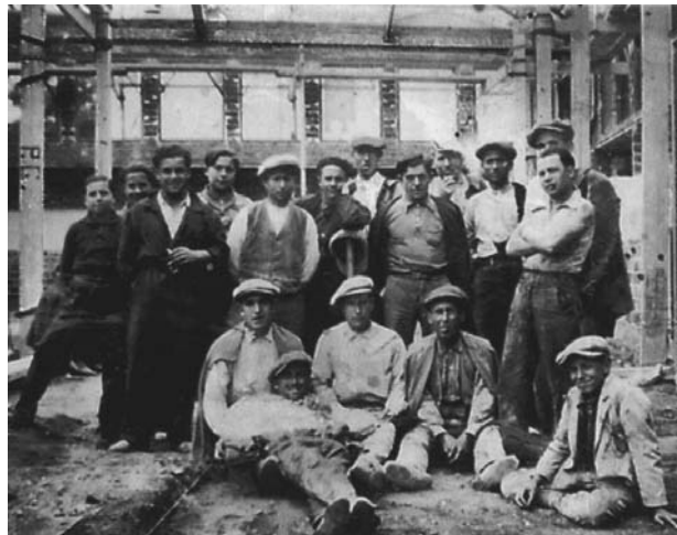
Obrers durant la construcció de l'edifici (AMCNM-Fons Galceran)
