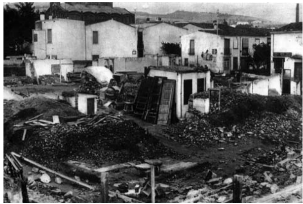
Enderroc de les cases per fer l'edifici (Arxiu Carles Sàiz)
