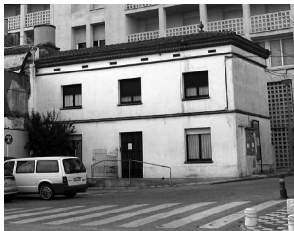
Edifici del Pavelló antituberculós de Canet, que es va enderrocar fa uns anys durant la darrera reforma de l'hospital Residencial Guillem Mas. (Arxiu ÀMBIT)
