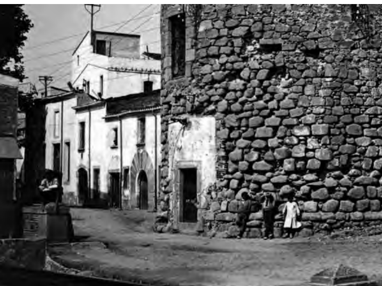
Porta «falsa» de la Torre. La veritable és la de sobre atès que a la torre s'hi accedia amb una escala de mà.
