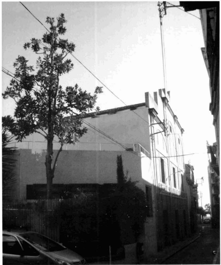
Edifici del Cinema Teatro Canetense al carrer de la Stma. Trinitat
