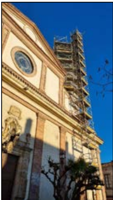
Campanar envoltat per una gran bastida (esquerra). Treballs de manteniment de l'agulla (dreta). Font: autor.
