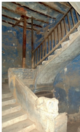
Fig. 7. Detall del lleó que presideix la barana de l'escala principal (Foto: Jordi Ibars)
