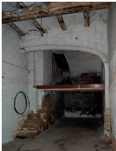
Fig. 5. Vista de la part dreta de l'arc carpanell que es localitza al vestíbul d'entrada i que emmarca l'escala principal (Foto: Jordi Ibars)
