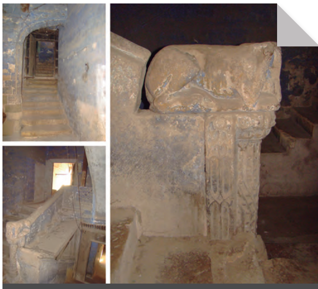
Fig. 3 - Vista general de l'escala monumental des de diferents angles i detall del lleó de pedra que presideix el pilar d'arrencada de la barana. (Fotografia M. Monjo-I. Pastor)
