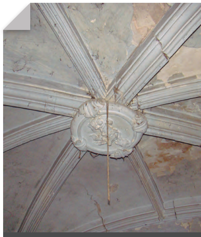
Fig. 4 - Detall de la clau de volta figurativa que corona el sostre de la capella de la planta principal del palau. (Fotografia M. Monjo-I. Pastor)
