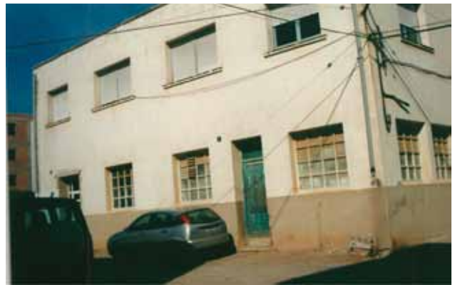
Façana davantera de la fàbrica de Muebles Gascó y Jornet. Foto: Ma. Mar Villabí.
