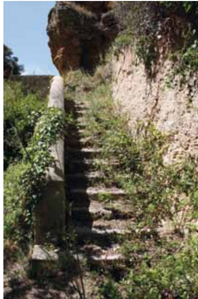
Túnel excavat a la roca i escales d'accés a l'edifici. Joaquín
