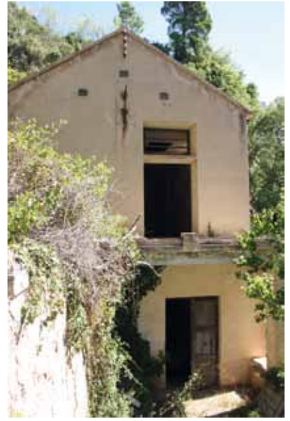
Façana de l'edifici, vista des de la sortida del túnel d'accés. El riu queda a la dreta.
