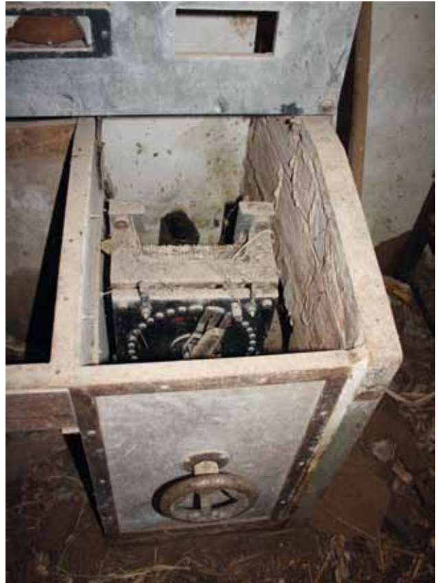
Part dreta de la taula de control i mesura, on s'ubica el regulador d'excitació de l'alternador que permetia ajustar la tensió de sortida al valor adient.
