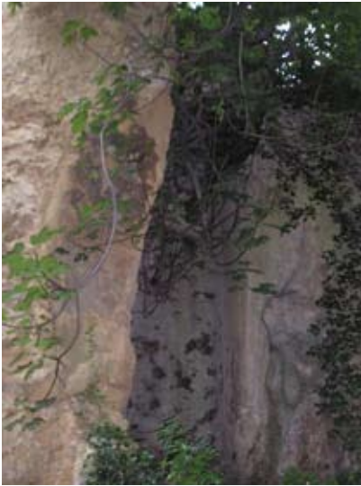
Fig.10, Canal practicat a la pedra per on baixava l'arbre de la trompa d'aigua
