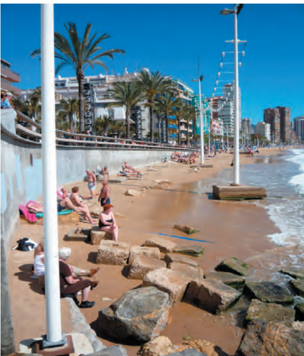
Foto 26. Blocs de ciment del Torrejón. Arnau Almiñana
