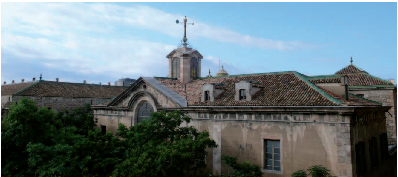
Cobertes i llanterna de l'edifici Fotos J. Carné. 2014
