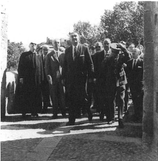
Inauguració de la restauració del pont de Besalú, 1965.
