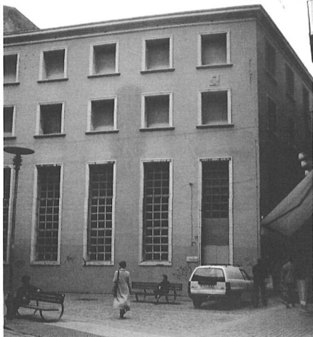
Façana de la central del Molí. Està prevista una propera remodelació.
