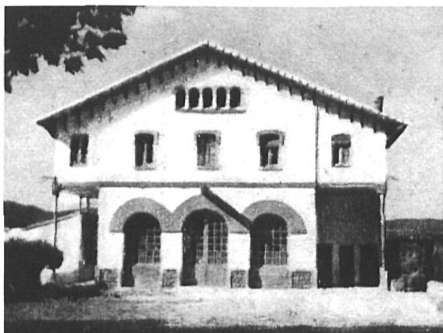
Cara sud de la central de Montfullà.
