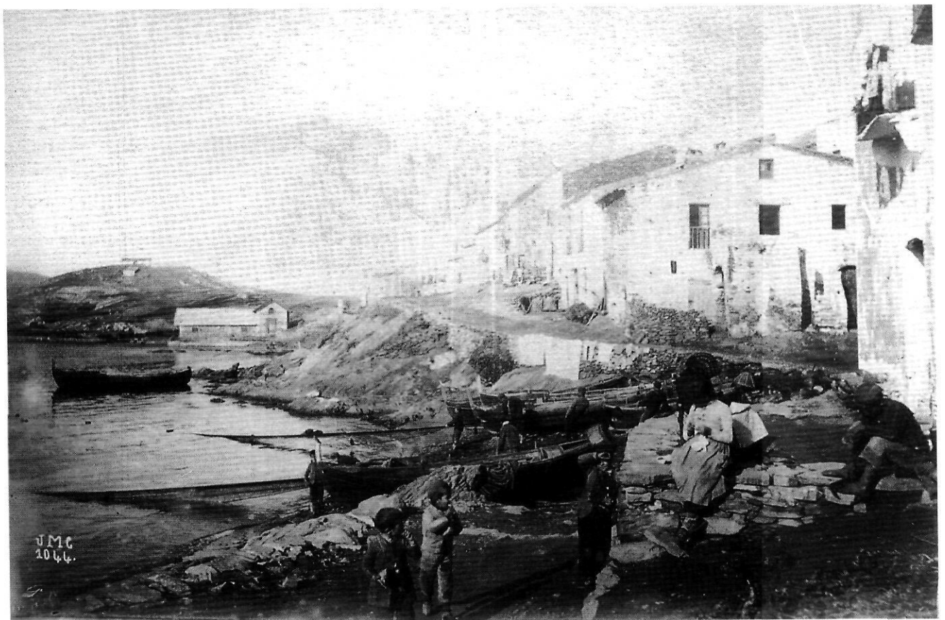
Port de la Selva: carrer del Mar.
