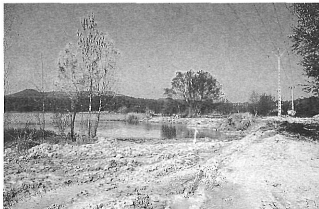
El dragatge al nord de l'estany es féu tancant la zona nord per tal d'aturar la ploma de llims i fangs i no afectar la resta de l'estany.
