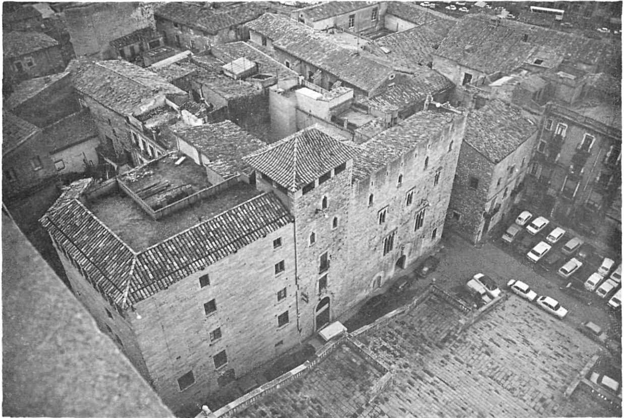
Fig. núm. 2. - Vista aèria de l'edifici de la Pia Almoina.
