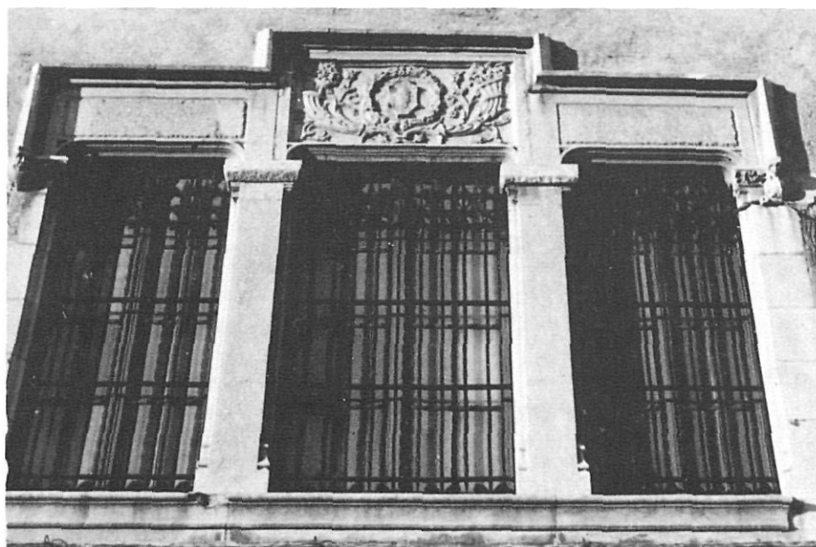
Fig. 8. Finestral del menjador, al cantó sud-est de l'edifici.
